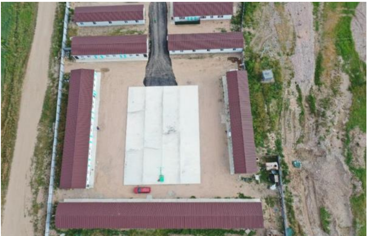
Figure 18: Camp site (km 148+630).
